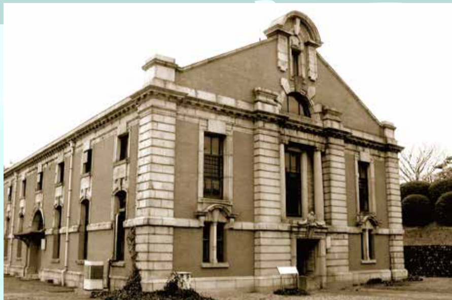
▲鍋屋上野第1浄水場ポンプ室 大正14年改築
