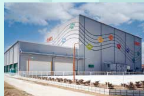
▲奥堀 島原営業所
