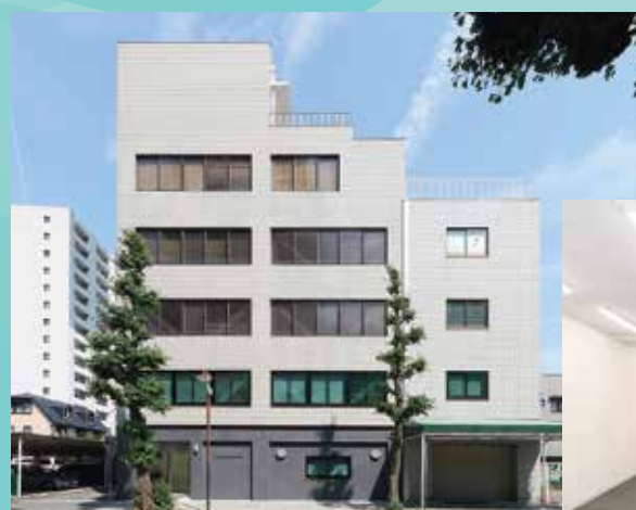
▲井上金物社屋改修&耐震
