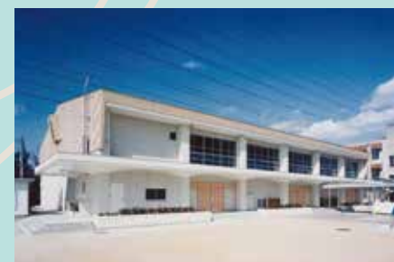
▲柴田小学校体育館
