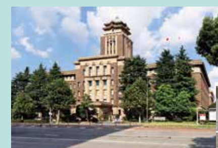
▲名古屋市役所本庁耐震工事
