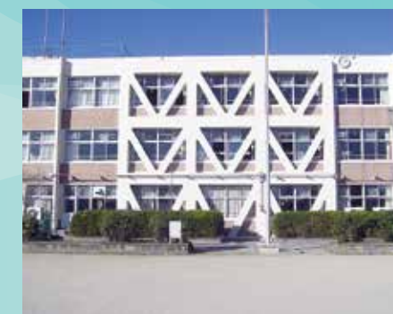
▲米野小学校耐震工事
